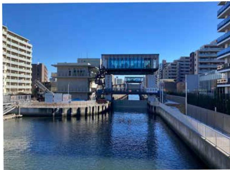
東京都江東区の小名木川に設けられた扇橋閘門。手前と奥のふたつの水門で最大3mの水位差を調整し、船を通行させる。かつて地下水の汲み上げにより地盤沈下が進み、内水面を海面よりも低く保つ必要が生じて建設された。竣工は1977年（文・写真：小松原純子）
