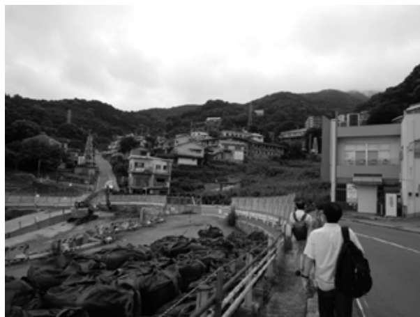
熱海市消防団第四分団詰所付近の状況（報告者撮影）
