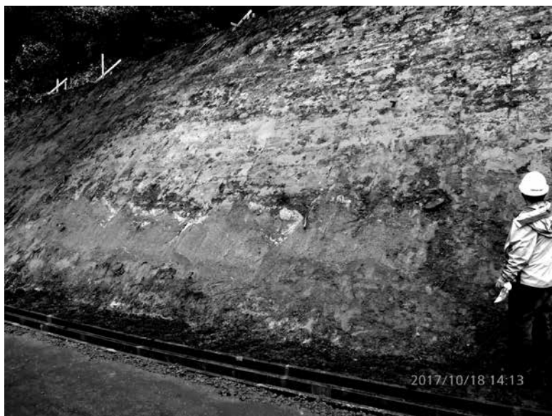
かわよう 南阿蘇村河陽地区の県道 149 号線法面に現れた階段状正断層群。人物の腰から胸にかけての位置にある草千里ヶ浜降下軽石が切られている。この法面は既に被覆されており、他の露頭も短期間で消滅することが多い。(撮影：奥野 充)
