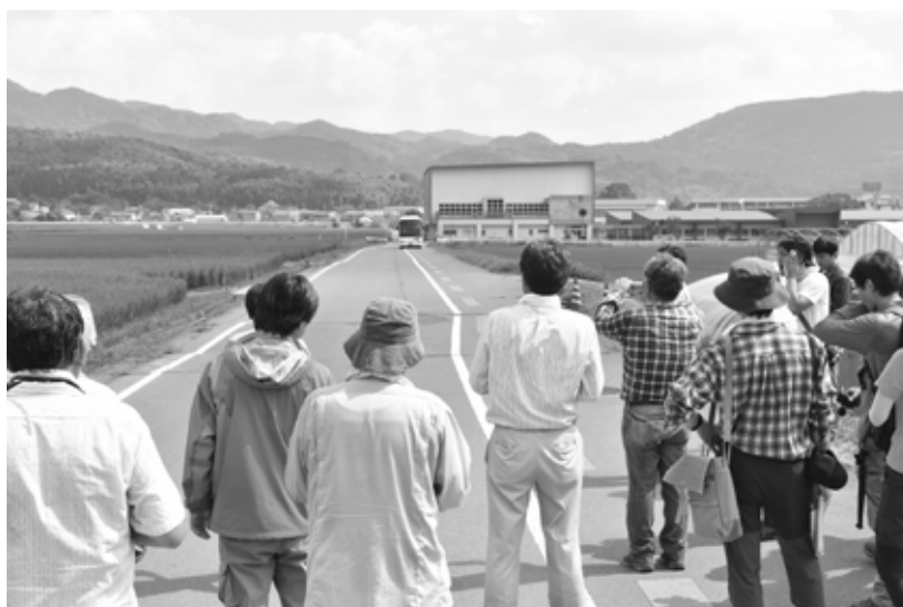
2017年福岡大会の巡検「熊本地震関連で巡る熊本～阿蘇」で訪れた益城町の木山低地に出現した地表地震断層。舗装道路の白線をみると、断層運動によって1m弱の右横ずれが生じたことが分かる。(撮影者：吾妻 崇)
