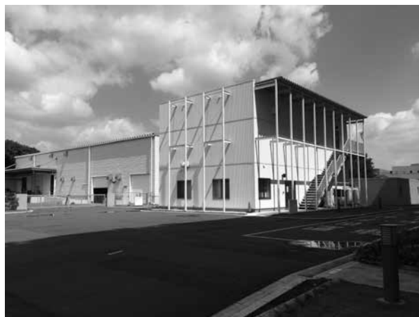
図2. 東京大学大気海洋研究所の加速器質量分析装置が設置されている実験棟
