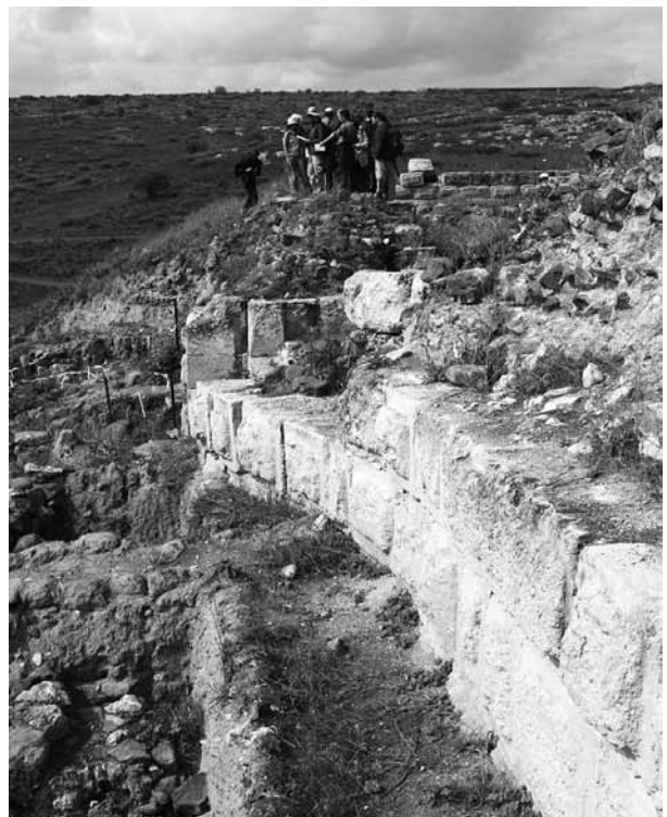
ガリラ湖北方、Vadum Iacob 遺跡南側の十字軍時代の城壁に見られる左横ずれ変位 (2.15 m)。
