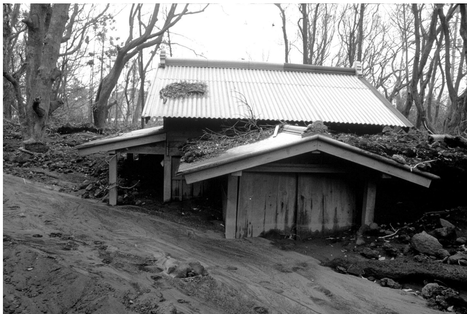
火山泥流で埋まった三宅島赤場暁北の椎取神社。三宅島では噴火後火山斜面の侵食が増し、溪流が泥流で埋められた。神社社殿は、軒下まで埋まったが、その後ゆっくりした洗掘によって溪床が約80cm低下し、社殿の側面が見えるようになった。(山崎晴雄 撮影)
