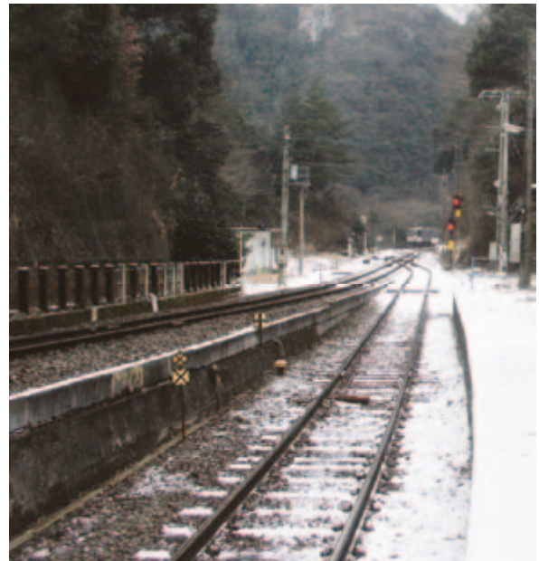
坪尻駅は線路の勾配が急なため、スイッチバックになっています。 いったん駅を通り過ぎた列車が停止し、駅に向けて逆送してきます。
