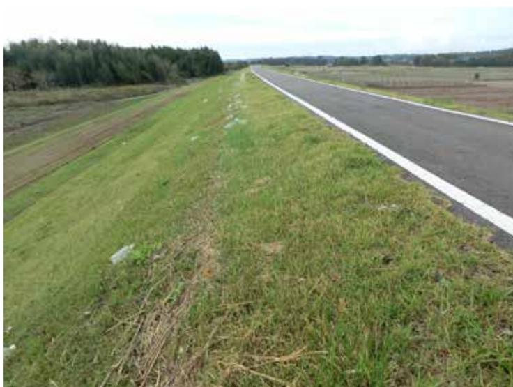
令和元年東日本台風（台風第 19 号）は、那珂川流域などに洪水被害をもたらした。洪水後、那珂川左岸の堤防法面（河口から約 22.5 km 上流）にはペットボトルや草本が残された。これらの位置にもとづいて洪水時の水位を推定できる。2019 年 10 月 20 日撮影（堀 和明）
