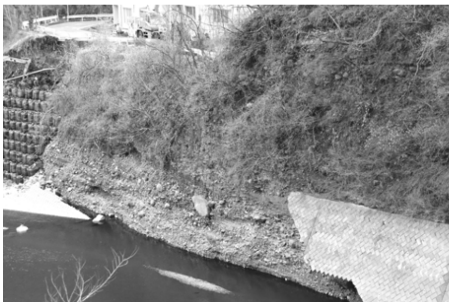
昨年の台風19号の増水によって擁壁が流された桂川（相模川）右岸（都留市田野倉）。擁壁に隠されていた桂川の河川堆積物と、その上に堆積する富士相模川泥流堆積物（厚さ約10m）が好対照をなす。（撮影：白井正明）
