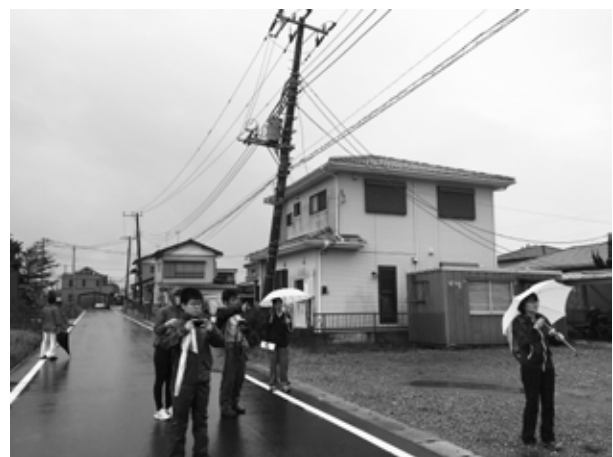
図 2. 潮来市付近。一部が地盤沈下した住宅と傾いたままの電柱（小森次郎撮影）
