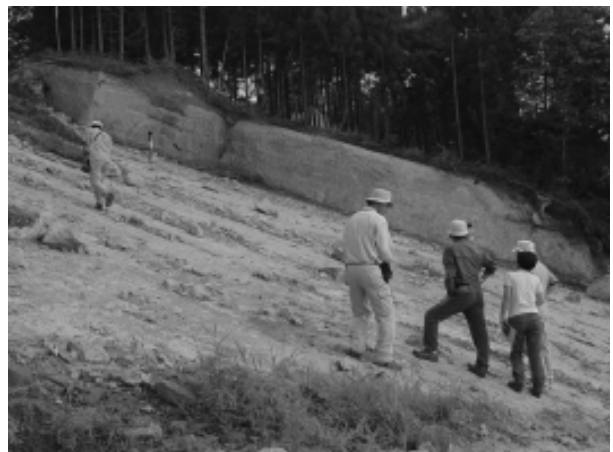
小千谷市横渡の層理面滑り崩壊
