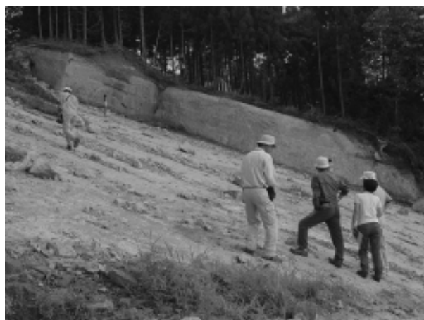
小千谷市横渡の層理面滑り崩壊
