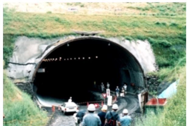
古富士泥流をもとめてトンネルへ
